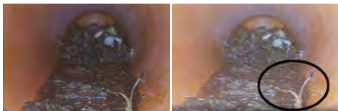
Imagen de una tubería durante la inspección.
