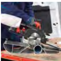
Corte de tubos
